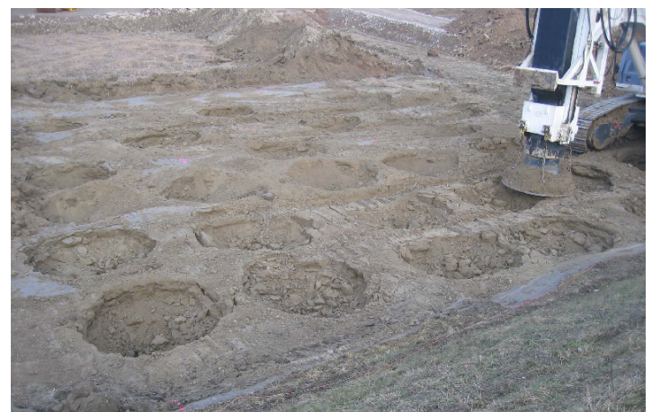
Bild 2. Verdichtungsmuster 3: (a) Primärraster (1. Übergang [„1“ und „2“] und 2. Übergang [„3“ und „4“]) und Sekundärraster („Finishen“ [„5“]) (aus [9]), (b) Foto – 2. Übergang (aus [1])
