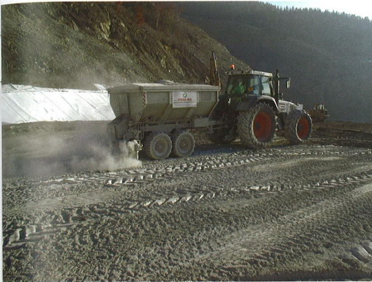
Aufstreuen des Bindemittels
