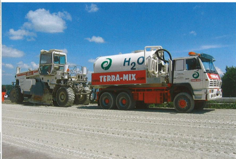
Wasserzugabe für eine gute Verdichtung
