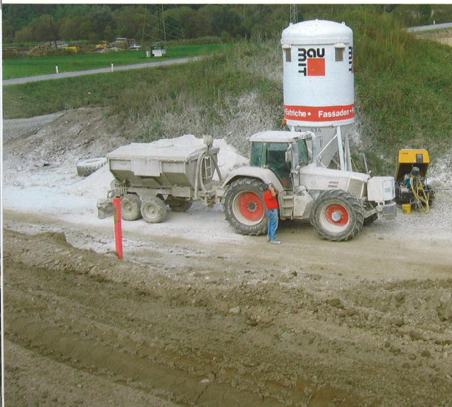
Bindemittellager auf der Baustelle
