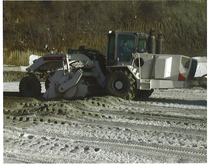
Einfräsen des Bindemittels
